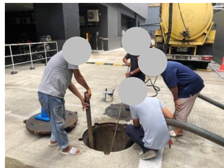
สูบลากตะกอนระบบบำบัด
