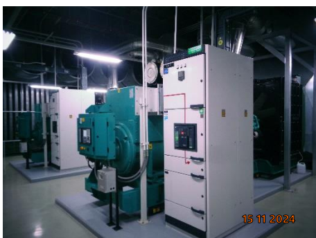
ภาพที่ 2.2-8 เครื่องกำเนิดไฟฟ้า
