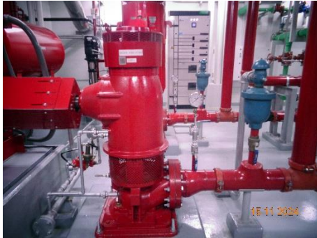
ภาพที่ 2.2-32 เครื่องสูบน้ำดับเพลิงแบบดีเซล
