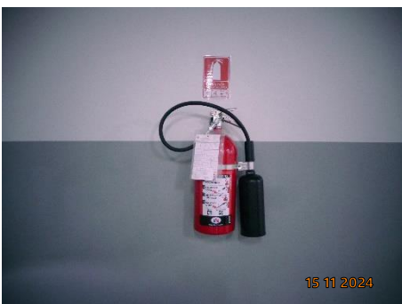
ภาพที่ 2.2-36 ถังดับเพลิงมือถือชนิด CO 2
