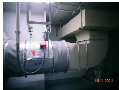
ภาพที่ 2.2-61 พัดลมระบายอากาศบริเวณพื้นที่จอดรถ
