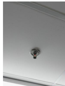
ภาพที่ 2.2-28 หัวกระจายน้ำ (Sprinkler)
