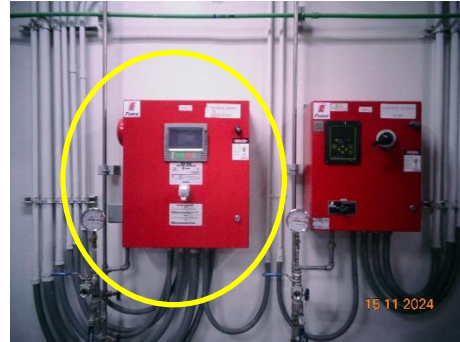
ภาพที่ 2.2-32 เครื่องสูบน้ำดับเพลิงแบบดีเซล
