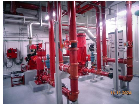
ภาพที่ 2.2-34 ระบบจ่ายน้ำดับเพลิงอัตโนมัติ
